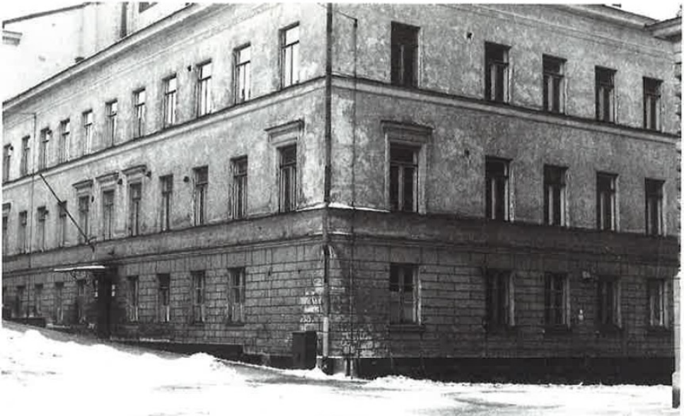
Kuva 1. Vanha farmakologian laitos Hallituskadun ja Ritarikadun kulmassa v. 1961; sisäänkäynti on Hallituskadulta vasemmalla. (Kuva kirjasta ”50 vuotta suomalaista farmakologiaa”, toim. Iisalo, Klinge, Mattila).
